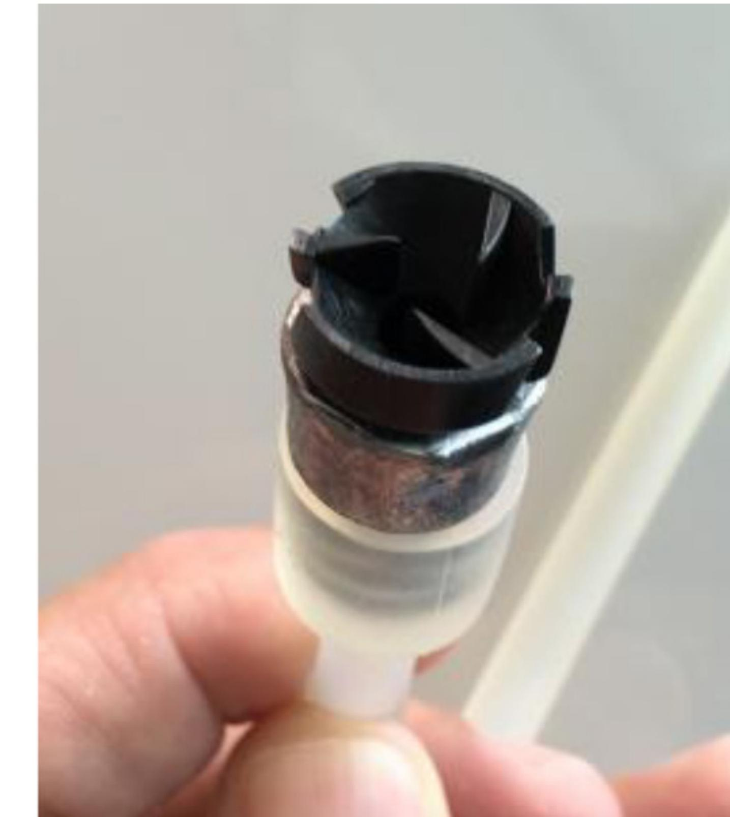
Paletele rotor - pentru a permite tubului să se rotească
